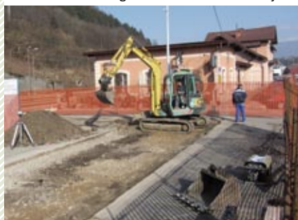
Sito pilota – stazione ferroviaria di Kranj
