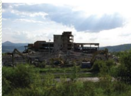
Demolizione dell'edificio nell'area degradata
