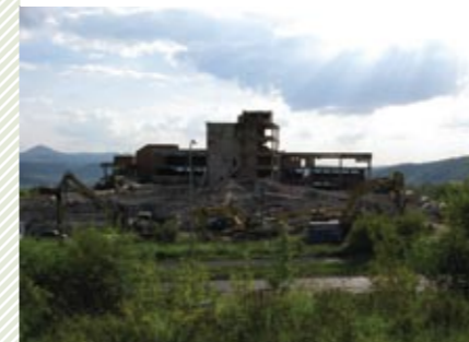
Rozbórka budynku na zdegradowanym terenie
