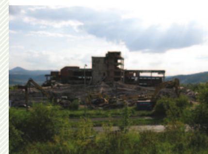
Demolice budovy v postiženém území
