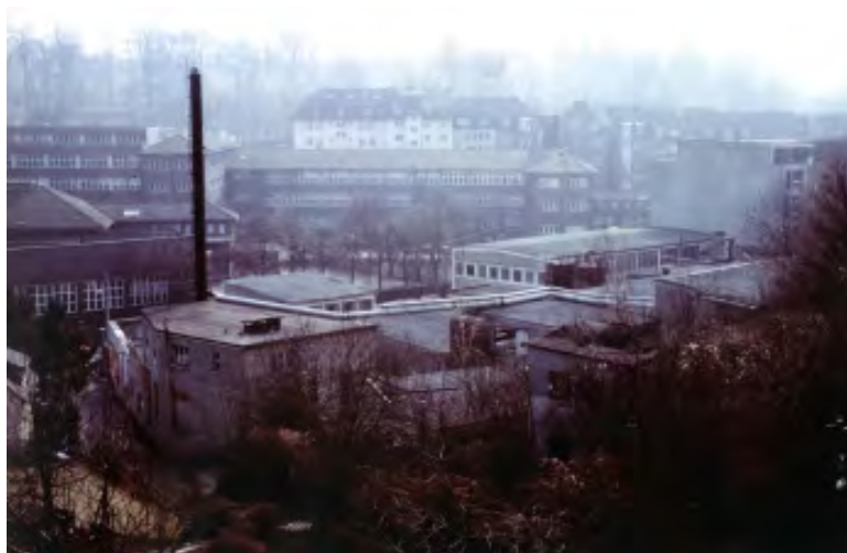
Abb. 6: Luftbild von Lämmleshalde vor Abbruch und Sanierung
