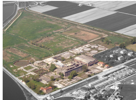
Abb. 26: Luftansicht der ehemaligen Zuckerfabrik
