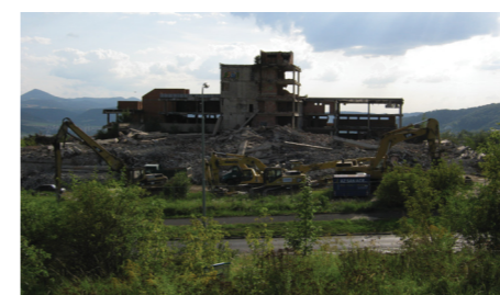
Abb. 32: Gebäudeabbriss auf einer Brachfläche
