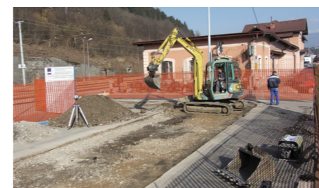
Abb. 25: Informationsstand in der Bauphase
