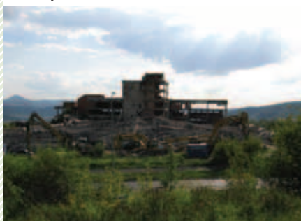
Rušenje zgradbe v degradiranem območju
